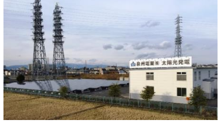
草津FAセンター 太陽光発電設備(2014年)
