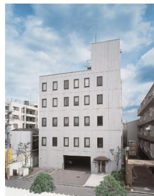
本社事務センターを新築開設(1989年) (現、本社)
