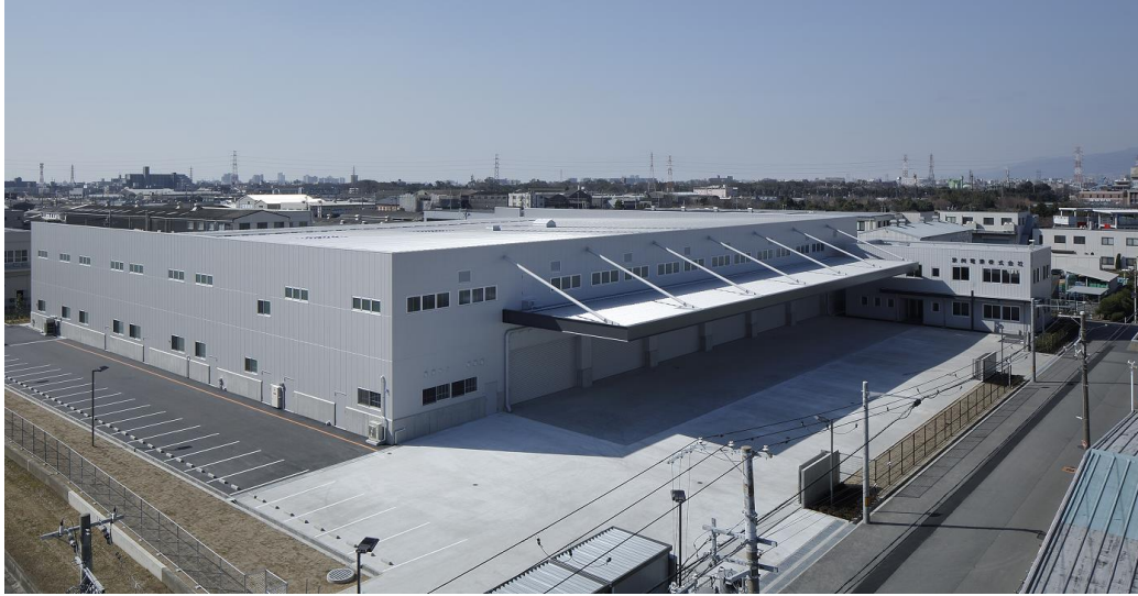
▲ 大阪物流センター（大阪府豊中市）
